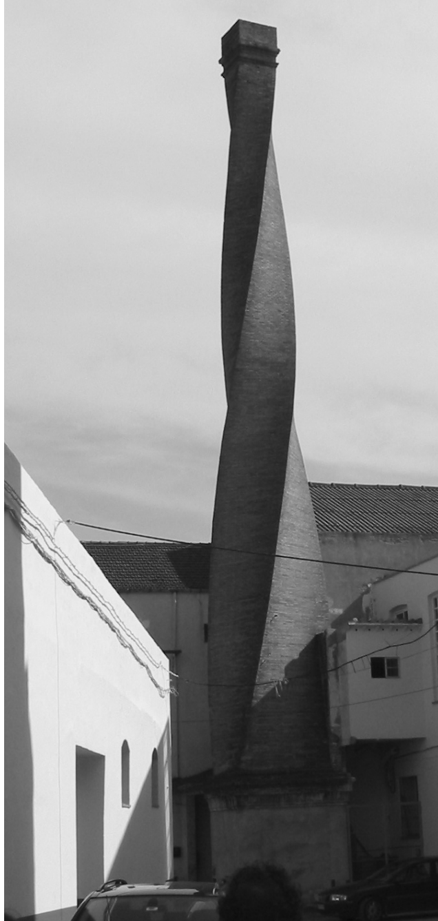
Spiral Chimney at Colònia Sedó
