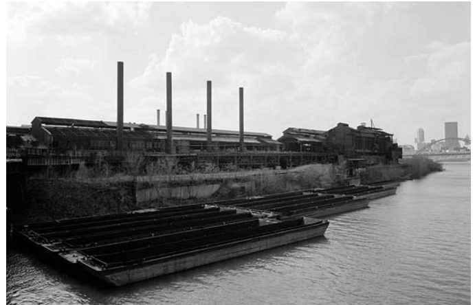
Jet Lowe, HAER PA-48
